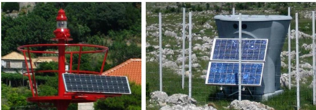
**Slika 2.5** Tipični primjeri upotrebe fotonaponskih modula - lučko svjetlo (lijevo) i uređaj za mjerjenje karakteristika vjetra (desno) (Izvor: EIHP)
